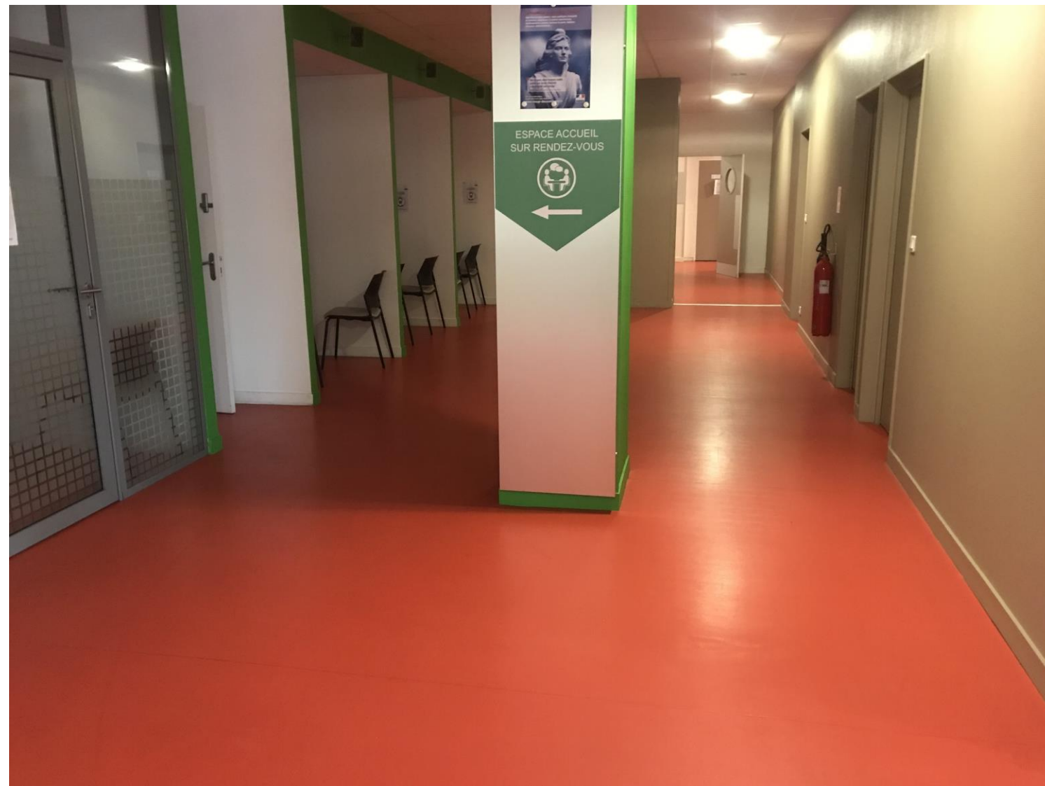
Sol avant rénovation
