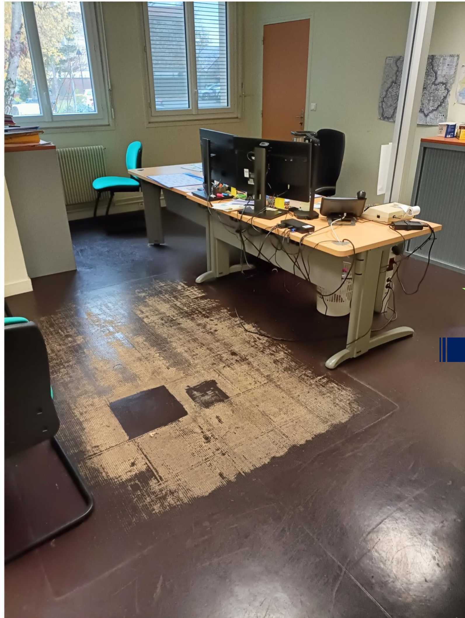
Sol avant rénovation
