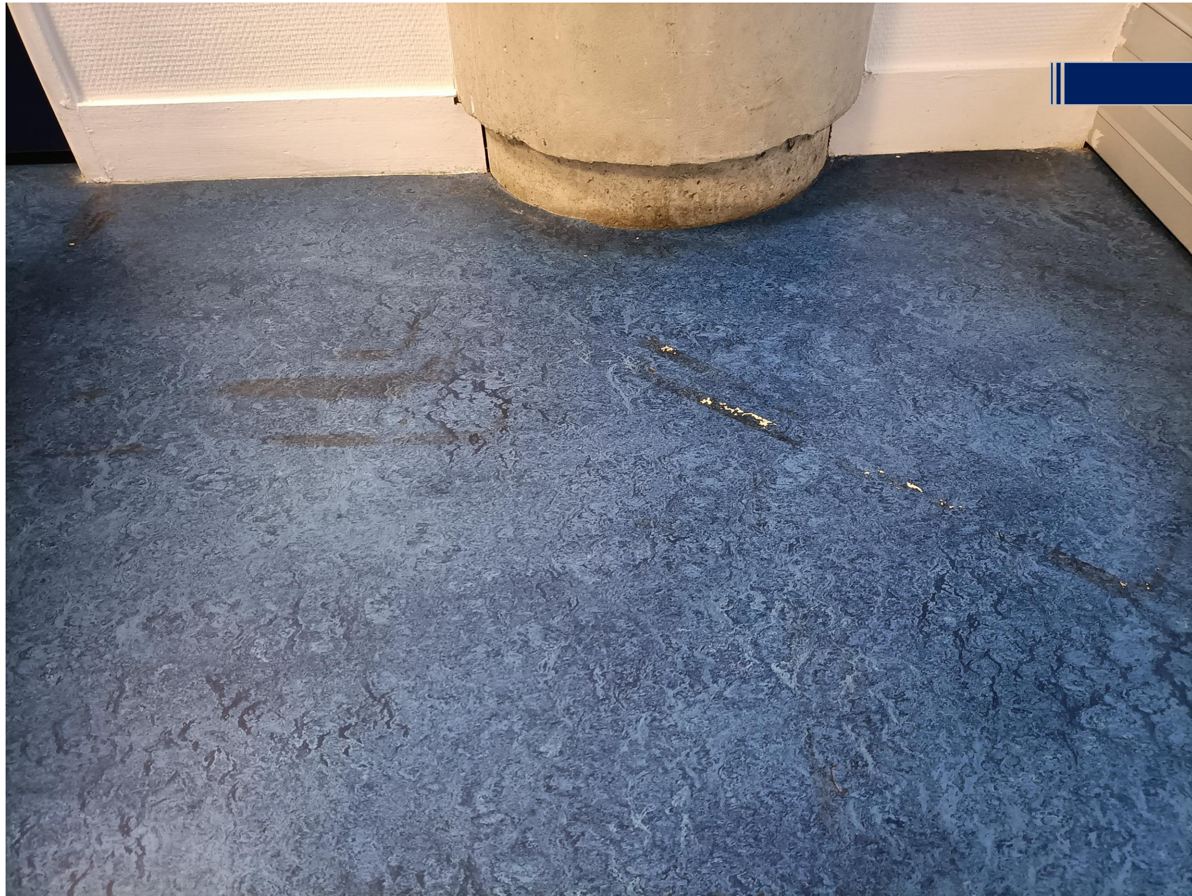
Sol avant rénovation
